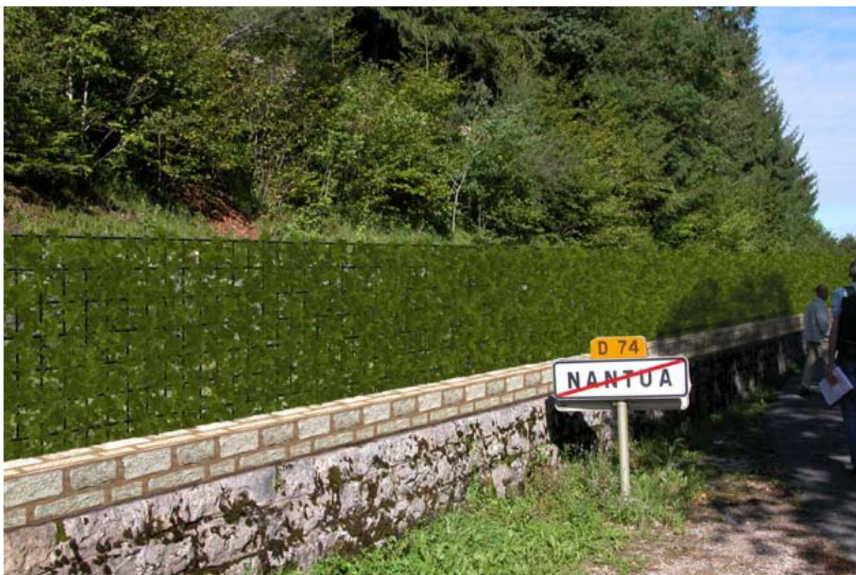
Mur anti-bruit paysager le long de la ligne du Haut-Bugey à Nantua
